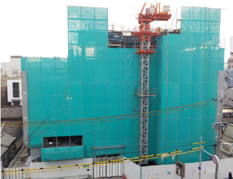
▲工事現場全景
