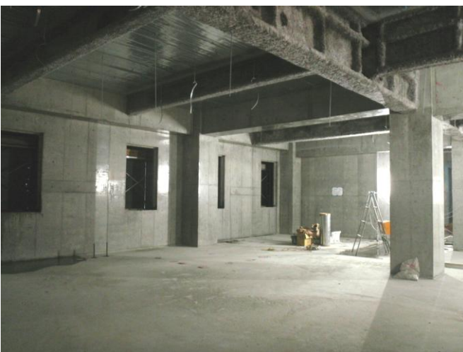
▲2階内装仕上げ状況
