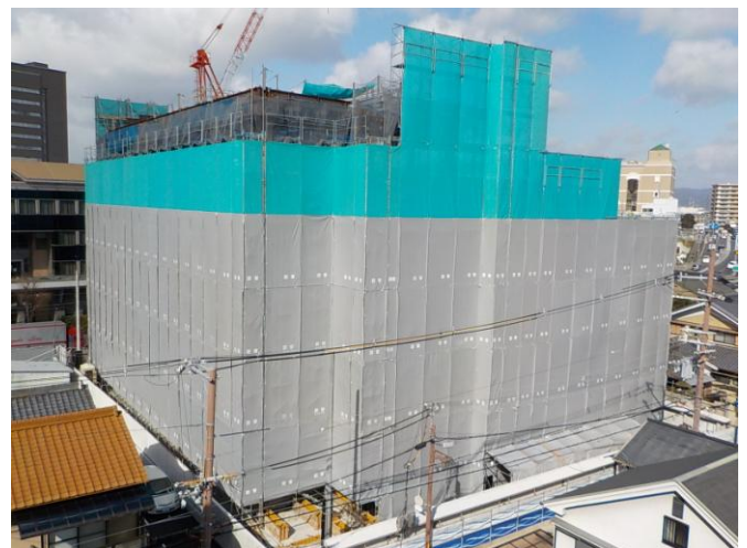
▲工事現場全景
