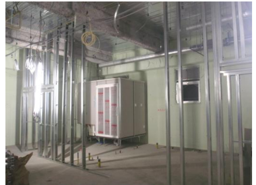
▲1階内装仕上げ状況
