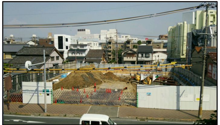
工事現場全景
