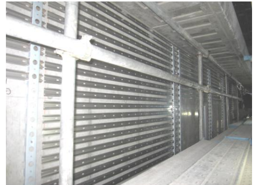
▲外壁タイル下地取り付け状況
