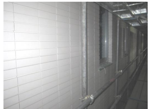
▲外壁タイル張り付け状況
