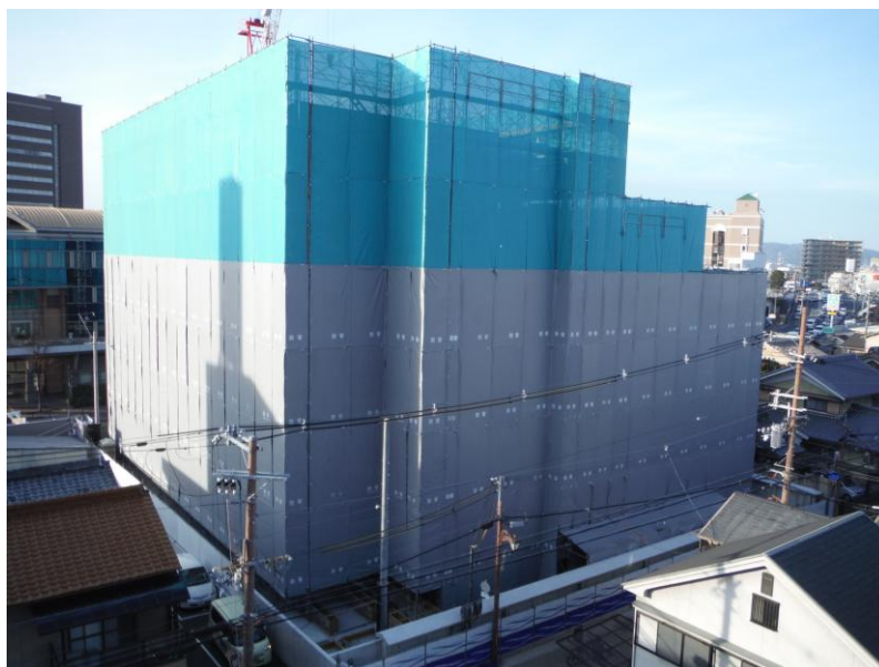
▲工事現場全景
