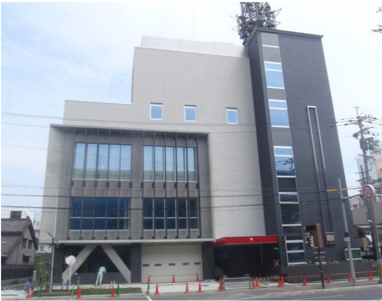
▲工事現場全景 (平成 27 年 6 月 2 日 ラポール枚方側より撮影)
