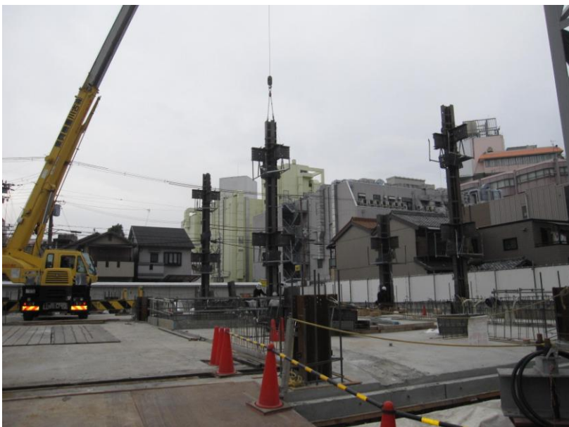
▲鉄骨組み立て状況①
