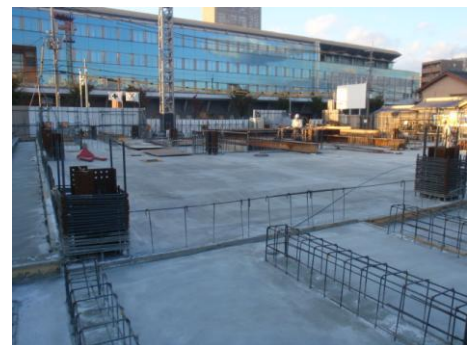
▲1階床コンクリート打設完了状況
