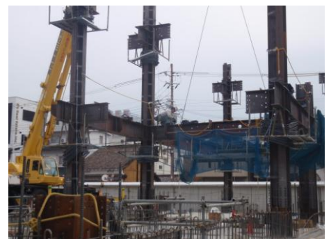
▲鉄骨組み立て状況②
