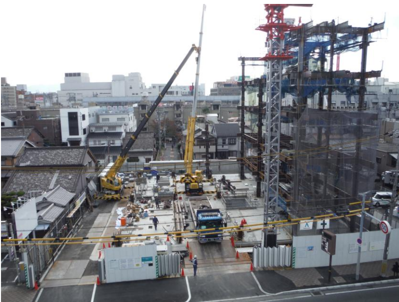
▲工事現場全景
