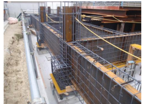
▲1階梁の配筋状況
