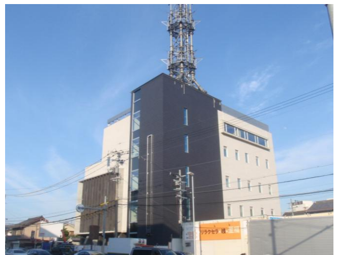
▲工事現場全景
