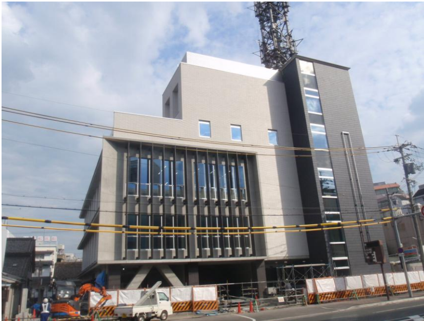
▲工事現場全景
