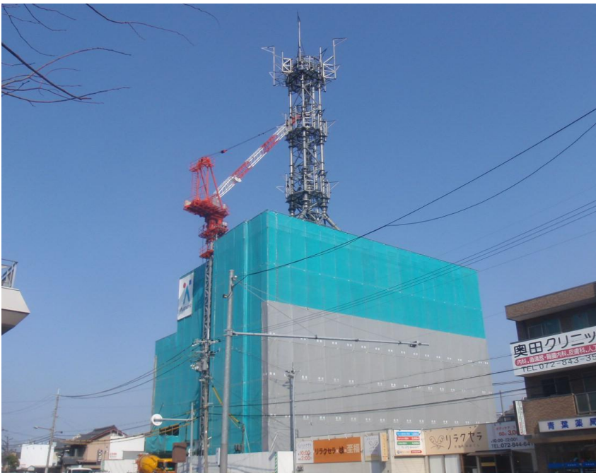
▲工事現場全景
