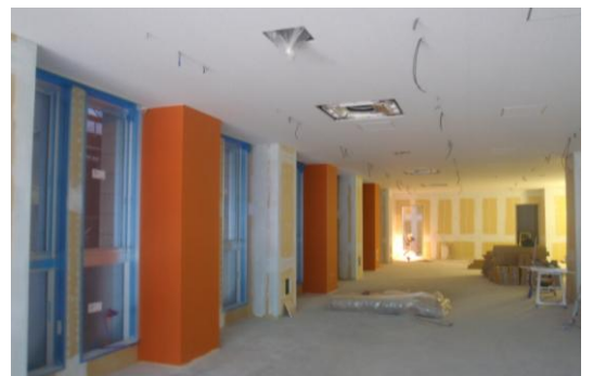
▲2階内装工事状況
