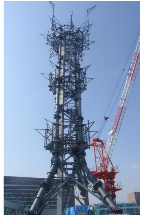
▲鉄塔組み立て完了状況
