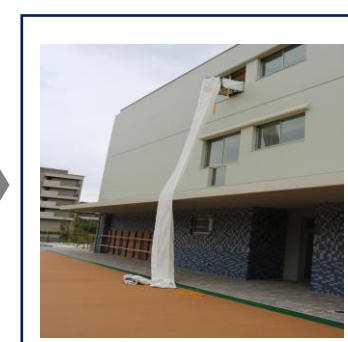
上部の設定完了を 避難階から見た様子
