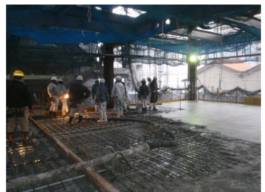
▲コンクリート打設状況
