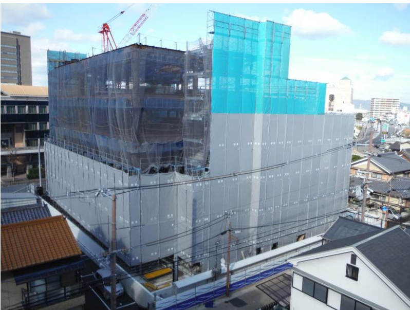
▲工事現場全景
