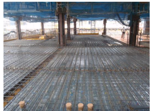
▲2 階床の配筋状況
