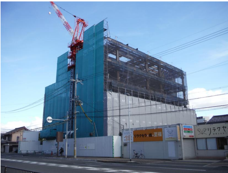
▲工事現場全景
