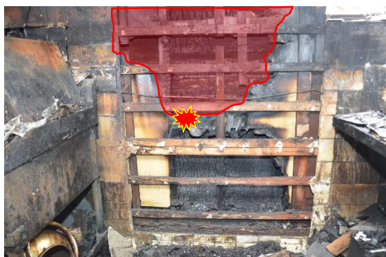
↑ タイル及びこんろ等を取り除いた状況
