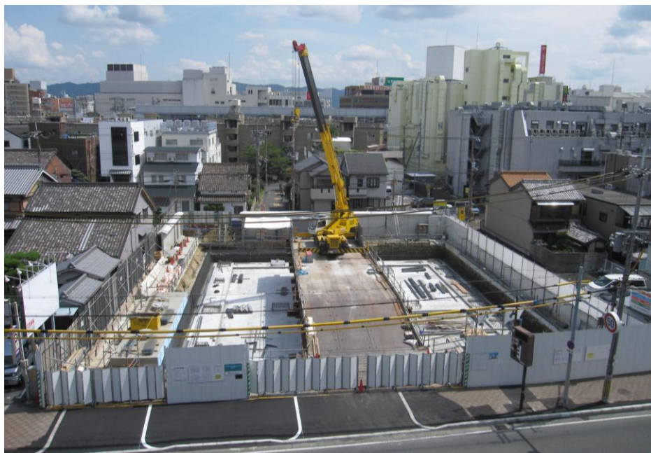
▲工事現場全景
