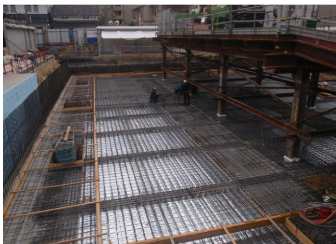
▲コンクリート打設前の状況
