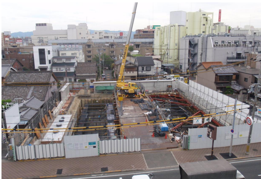
▲工事現場全景
