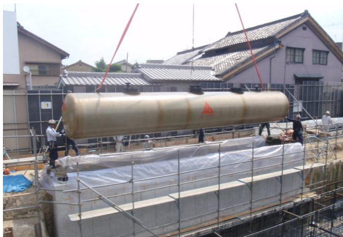
▲地下燃料タンク設置状況
