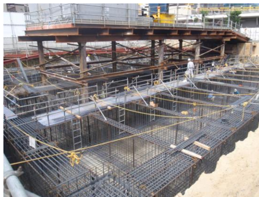
▲鉄筋の組み立て状況
