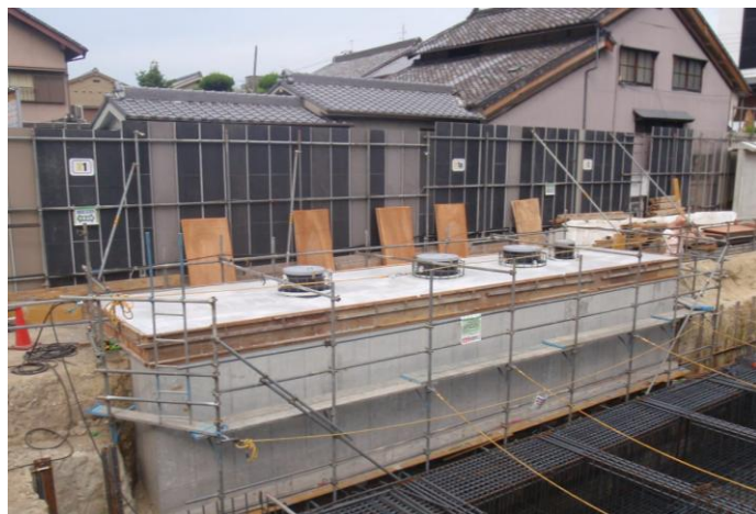
▲地下燃料タンク設置工事完了状況
