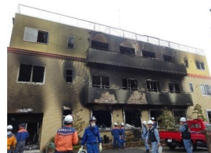
現地調査の様子 （出火建物外観）
