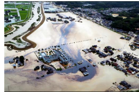
危険物の流出状況
