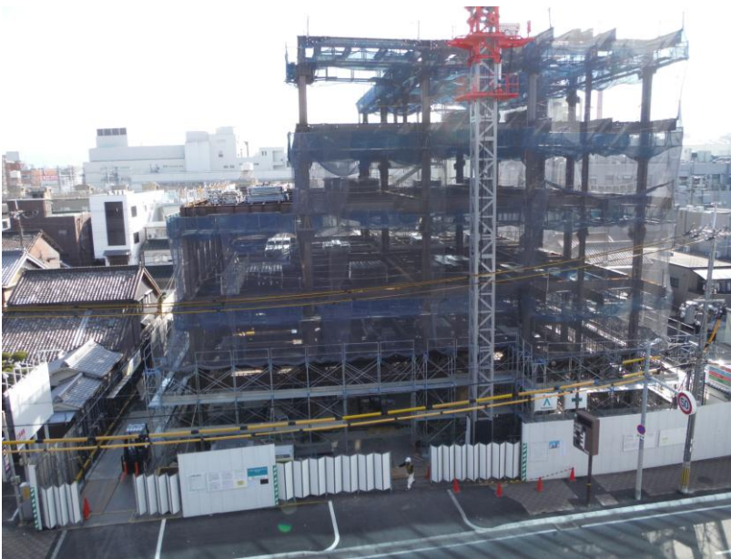
▲工事現場全景
