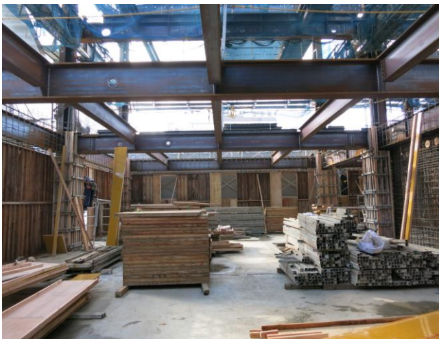
▲型枠組み立て状況
