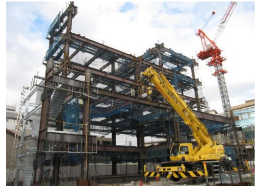
▲鉄骨組み立て状況
