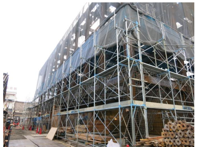
▲仮設足場の組み立て状況
