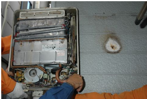
給湯器裏側の外壁の状況
